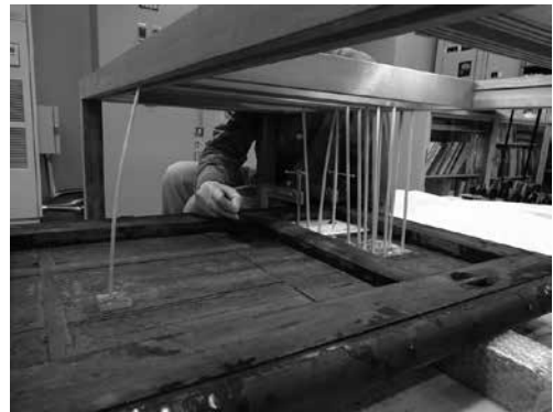
麦漆による剥落止め作業風景
