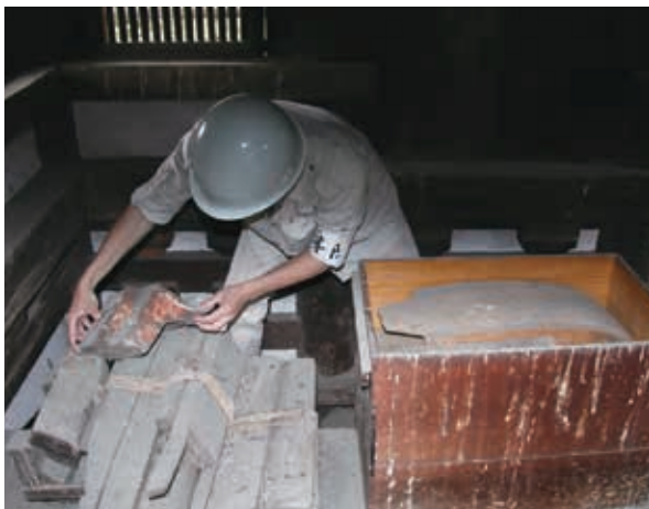
文化財建造物における旧塗装材料の現地調査
