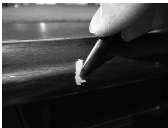
修復作業（損傷部の充填材の整形）
