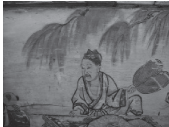
施工が完了し、顔料の剥落止めの終了した壁面
