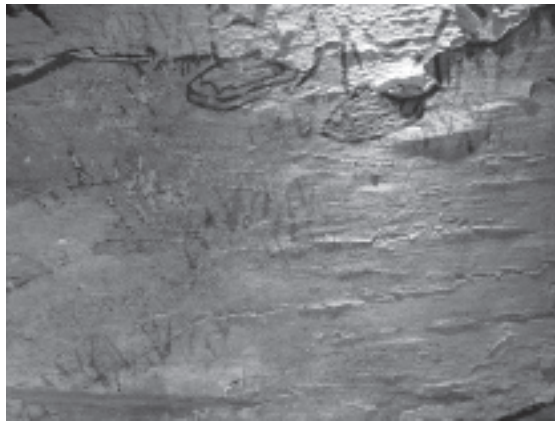
樹脂により剥離の生じている画面
