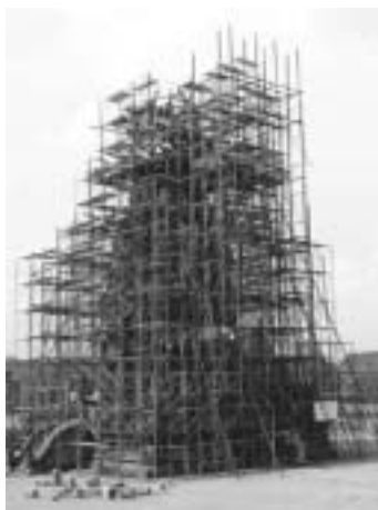
日本によって供与された足場によって、解体工事が行われているガルダ祠堂
