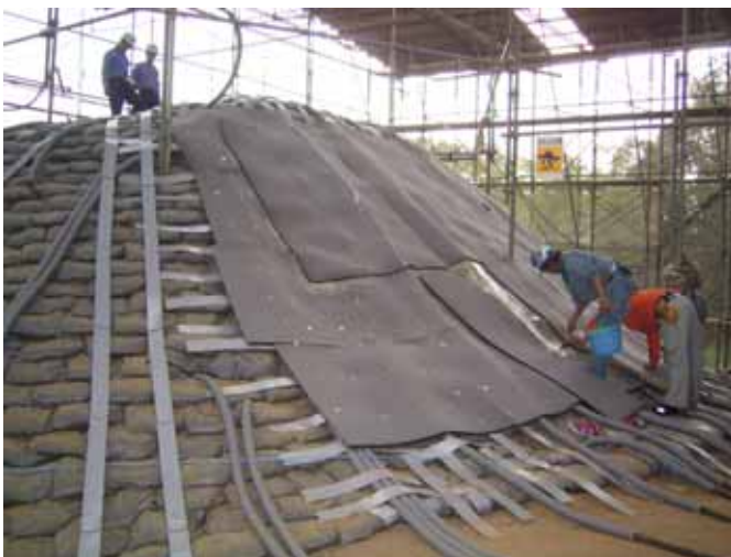
冷却管敷設工事
