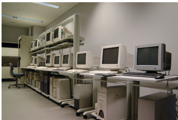
LAN 機械室のサーバー群
