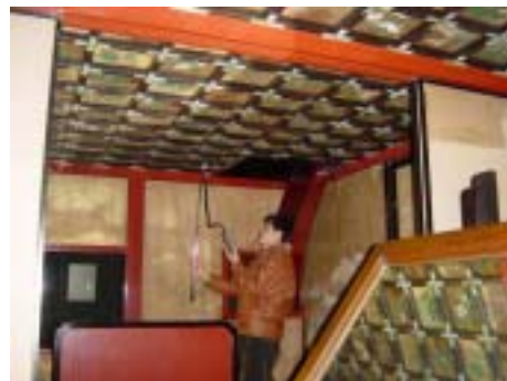
図2. 舟屋形内部の環境調査状況
