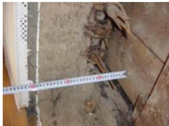
倉の土壁の断面構造
