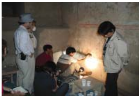
修復材料の試験施工
