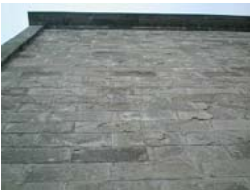
北海道開拓の村の歴史的石造建造物の南壁面 (札幌軟石、表面で剥落が見られる)
