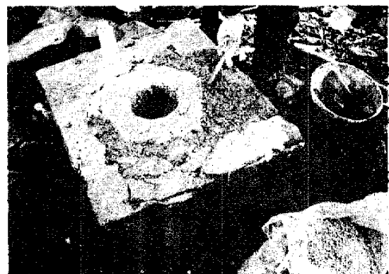
図-13 台石の樹脂擬岩による補修
