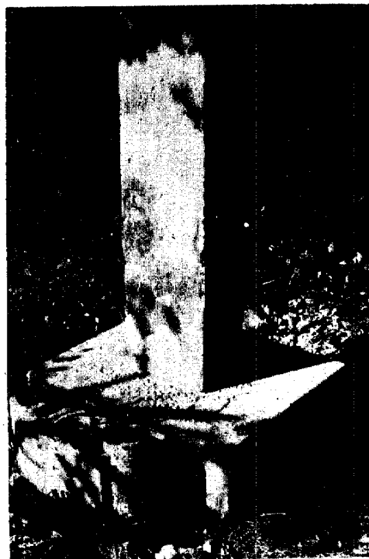
図-18 誕生地 修理後の塔身下部及び台石
