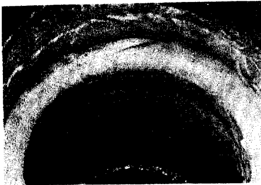
付図-8 笠接合部の F.R.P. 処置
