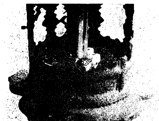
付図-2 火袋部分の支持棒と錆の集積
