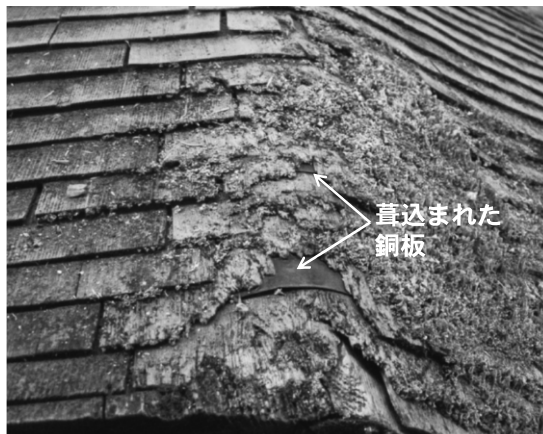
図1 こけら屋根に葺込まれた銅板
