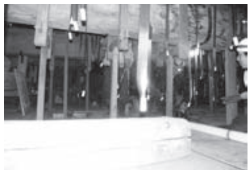
図23 経蔵（輪蔵）小屋裏
