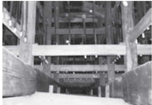
図19 輪王寺本堂（三仏堂）小屋裏
