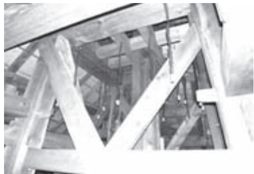
図21 中禅寺立木観音堂小屋裏
