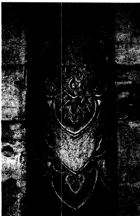
柱上部彩色 (処置後)
