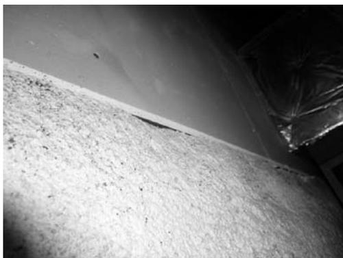
写真9 地下ピットから見上げた際、部屋の内壁のボード接合部にみられた隙間 2009年7月17日
