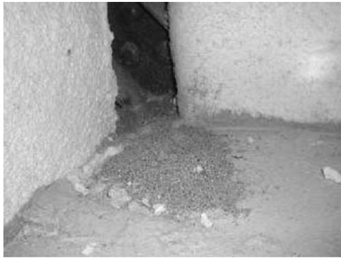
写真10 地下ピットに流入していた砂 2009年7月17日
