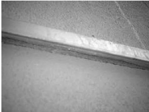
**写真6** 外壁の隙間に薬剤を含浸させたネットを挿入し、
