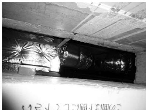
写真8 地下ピットから見上げた作業室の壁の裏側(作業室へ接続された空調ダクトのリタン口がみえる) 2009年7月17日
