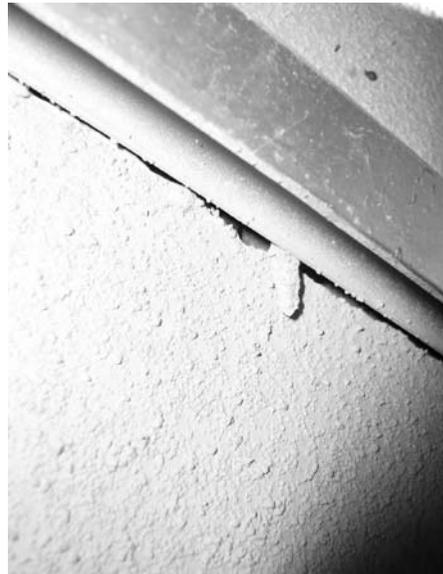
写真3 外壁の継ぎ目の隙間
