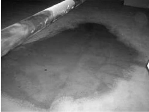
写真11 地下ピットの水溜り 2009年7月17日
