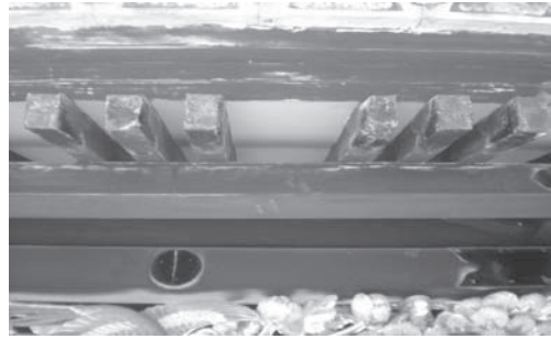
写真21 日光東照宮透塀の現況
