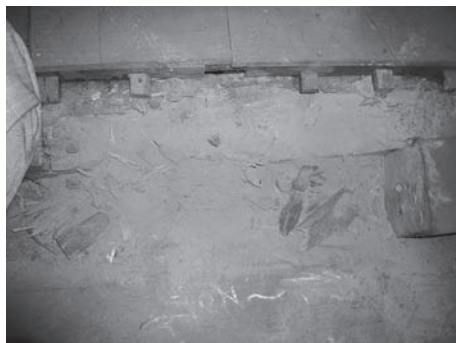
写真8 屋根裏、本殿天井部分の板の被害状況 (内部はほとんど粉末状になっている)
