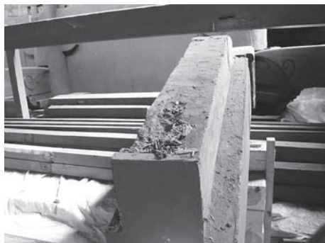
写真7 部材の被害状況(表面を薄く残し、 内部は粉末状となっている)
