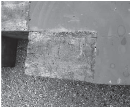
写真6 被害のあった部材 (1～3mmの虫孔があいている)
