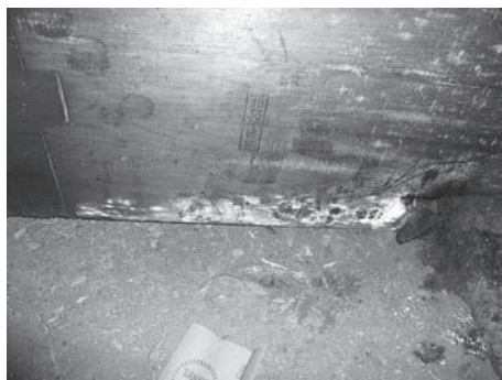
写真10 部材に発生しているカビ(中央の 白い部分)
