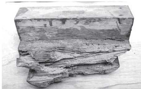
写真2 部材の接合部の被害例
