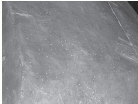
写真11 大仏背部に確認された虫孔
