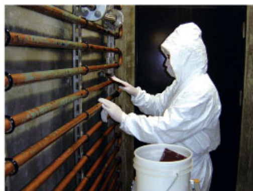
写真1 清掃作業の様子
