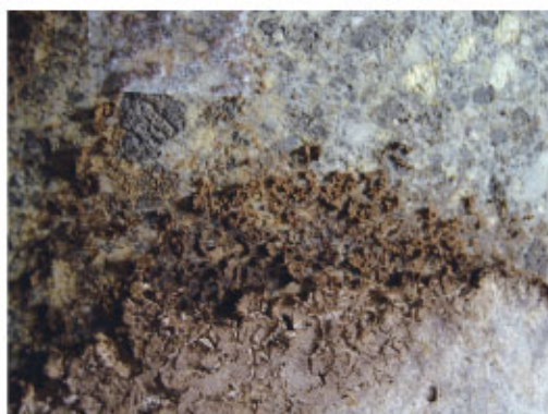
写真6 2006年2月3日 天井の漆喰の変化の例
