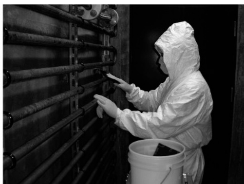
写真1 清掃作業の様子
