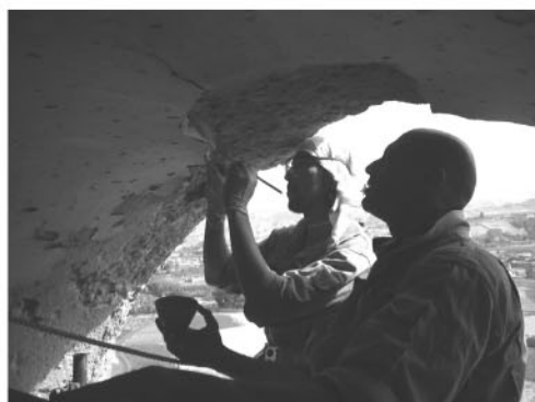
写真2 天井の大きく乖離した部分の処置
