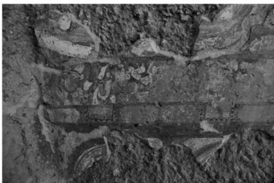
写真4 I窟座仏龕の天井部分 処置後
