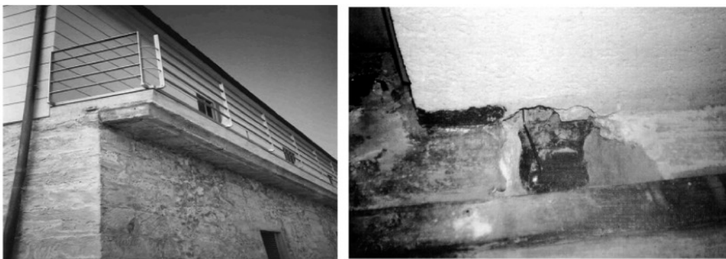
図8 バルコニー (左), 配水管部分 (右)
