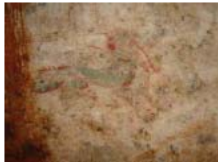
図22. 2004年9月6-7日の点検時に新たに発見された青竜前方の黒い汚れ
