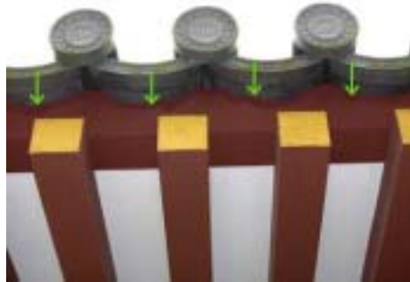
図3. 顔料付着原因の推定図 板を塗装した際の顔料が、はみ出して瓦にも付着したと考えられる。
