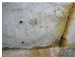
写真14. 2005年9月29日天井の穴（直径およそ1 cm）の例
