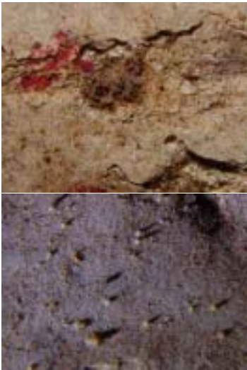
図20. 2004年7月15-17日の点検時に壁面にみられた粘性のある塊状の物質
