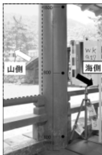
図1 丹塗柱の水分量計測
