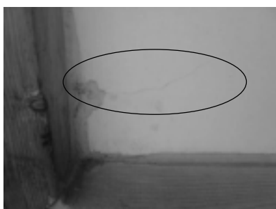
写真6 試験壁左隅(南西下角)で生じた亀裂 (2004/3/28撮影)と水染み
