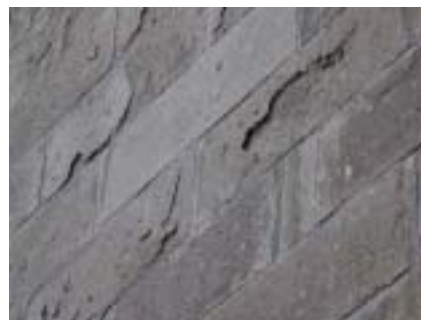
写真3 旧小樽新聞社南面の劣化状況
