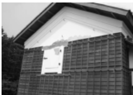
写真1 開拓の村にある剥落した漆喰壁の建造物（旧武井商店酒造部の土蔵）
