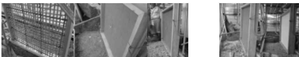
写真4 各工程毎の写真 左段：左から試験壁骨組み、だんご付け(下塗り)、大むら直し(中塗り)； 右段：左から小むら直し(中塗り)、仕上げ(上塗り)直後の写真
