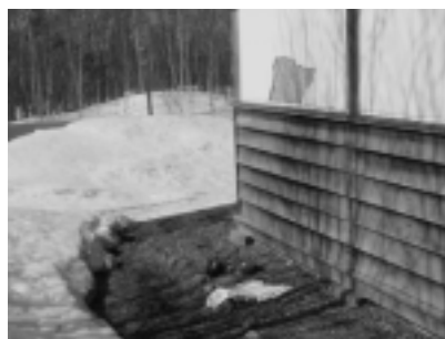
写真2 開拓の村にある剥落した漆喰壁の建造物（旧大石三省堂支店の土壁）
