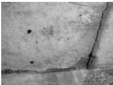
写真14. 2005年9月29日 天井の穴（直径およそ1 cm）の例
