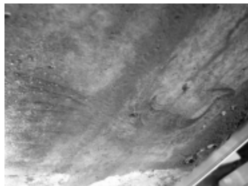
写真9. 2005年7月15日、石室南壁に発生していたカビ等(写真提供:修復技術部,川野邊渉)
