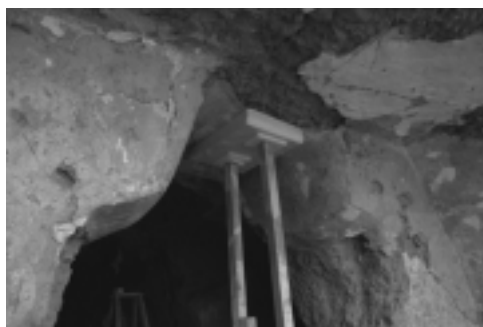
写真2 K窟入り口天井。グラウト材を施してしばらく押さえ接着した。
