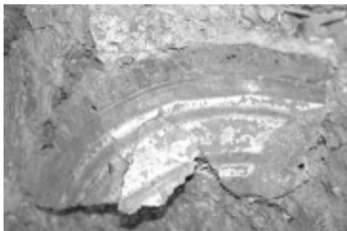
写真3 I窟天井。岩盤から剥離した箇所が落下する危険があった。
