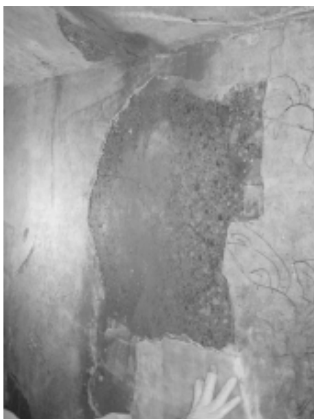
写真5 2004年8月に東壁の青龍を取り外した跡に見られたカビ (写真提供 川野邊渉)
