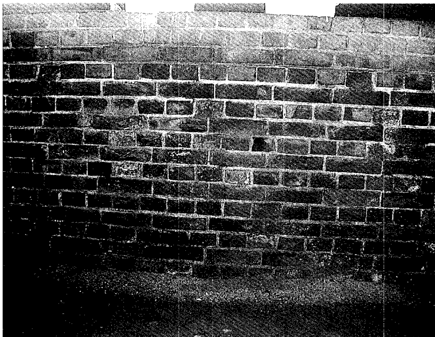
図5 試験施工前の二階西側内壁面（1999年9月）
