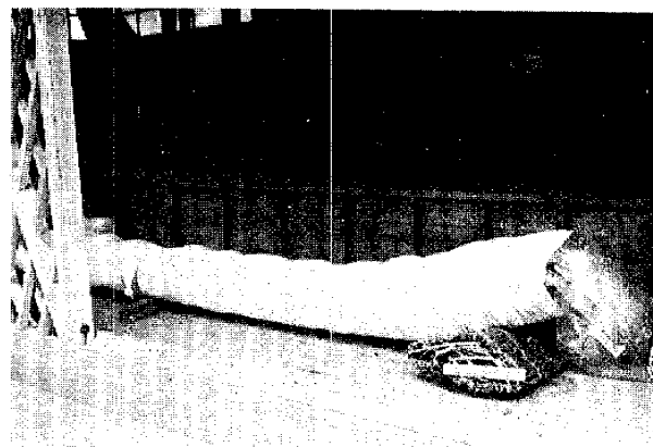
(13) 樹脂注入前の状態 (さらし布で巻く) (富津)
