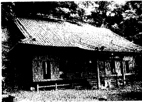
写真-1 薬師堂全景
