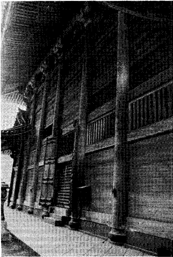
図-3 本堂の北面，中央に障子戸，その上方に連子窓が開いている。
