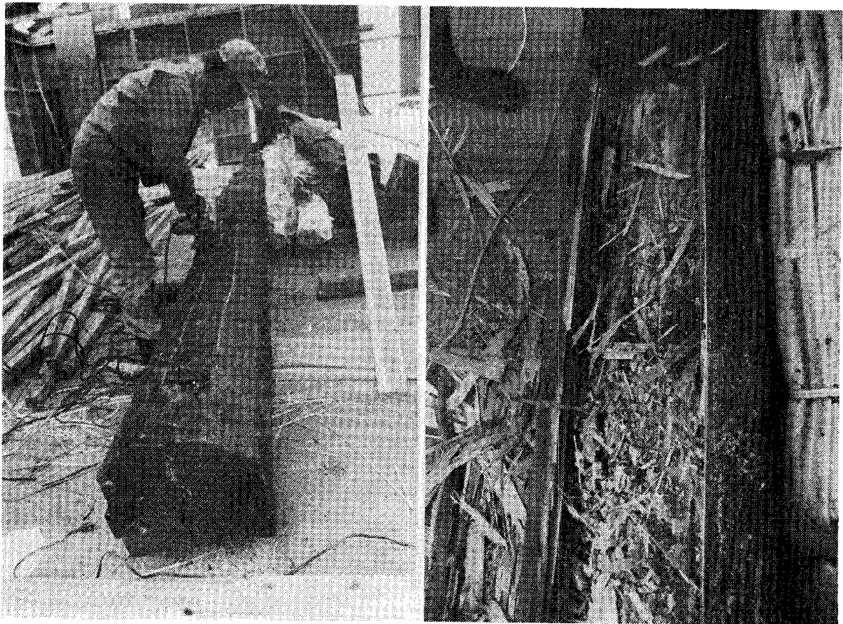
図一2 徳島県旧小要家の小屋梁
