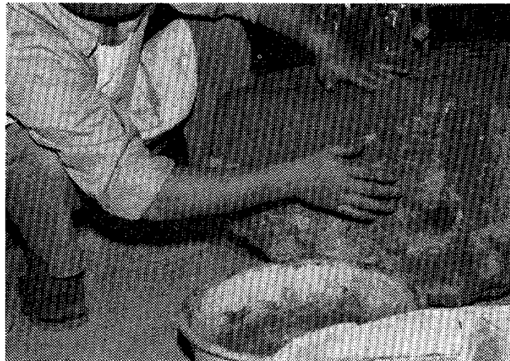
図一7 欠失部分の樹脂擬岩による補修
