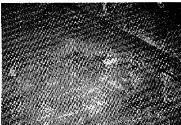
図-7 硬質ポリウレタフォームによる閉塞
