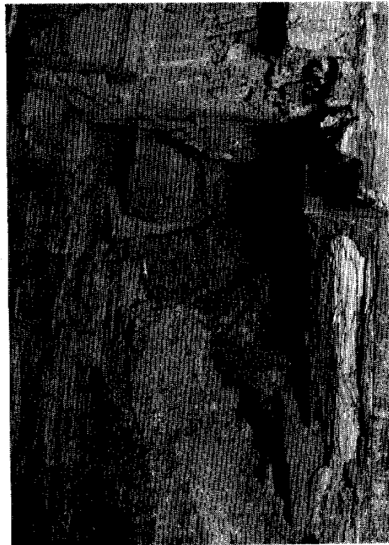
図-8 東側面中柱の腐朽(図7の拡大)
