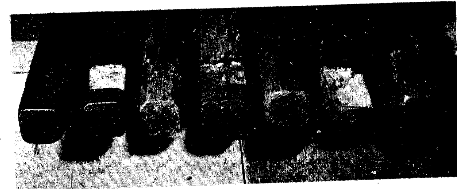
付図-5 垂木木鼻の整形処置
