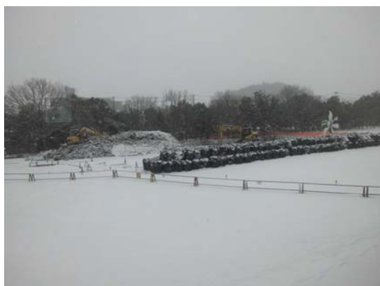
除染作業 前庭に穴を掘ってフレコンバッグを埋める(2014年2月8日)
