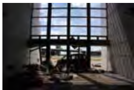
津波により失われたガラスドア
