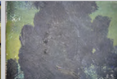
4. 画面には、砂汚れが付着
