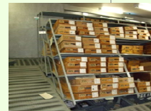
図2 浮島収蔵庫(収蔵棚崩れ)
