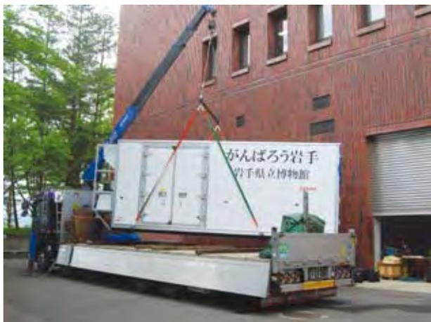
図 11 岩手県立博物館に設置された大型冷凍庫
