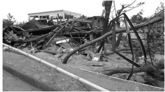
漁具収蔵施設の被災状況
