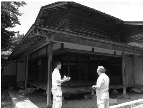
M 家住宅の被災状況
