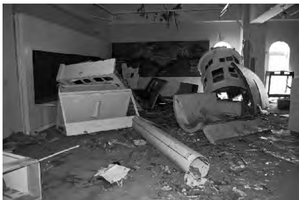
海と貝のミュージアム展示室の被災状況
