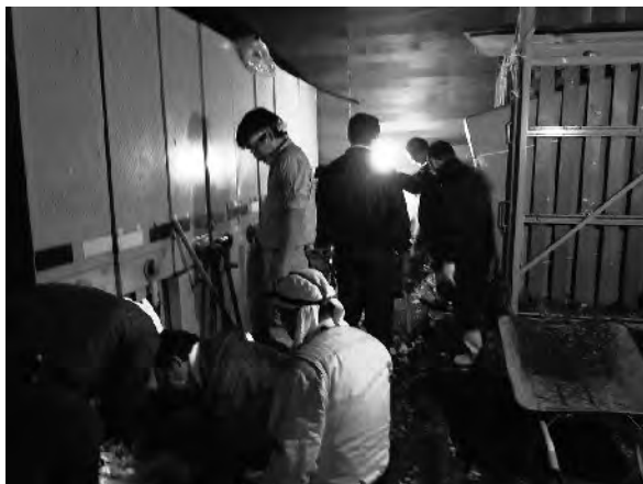
写真1 石巻文化センター1階美術収蔵庫内の土砂撤去（4月26日）
