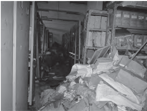
図画 13 瓦礫で踏み込めない文書庫入口付近
