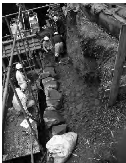
石垣の復旧工事が進む瑞鳳殿（仙台市青葉区）
