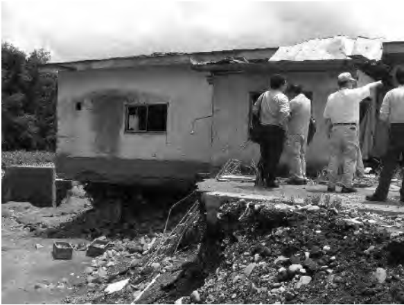
土石流によって基礎部分等が抉られ破壊された収蔵庫 (壁の汚れ部分までが浸水範囲)
